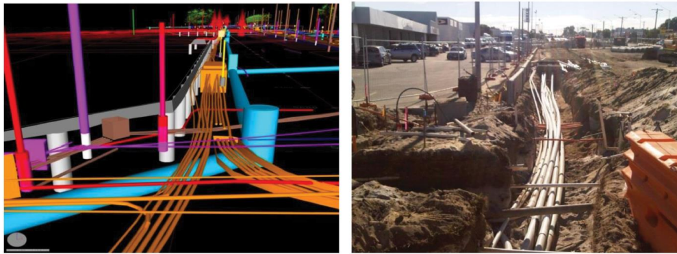
Figura 7 - Comparação do modelo virtual com o realizado em campo (Chong et al., 2016)
